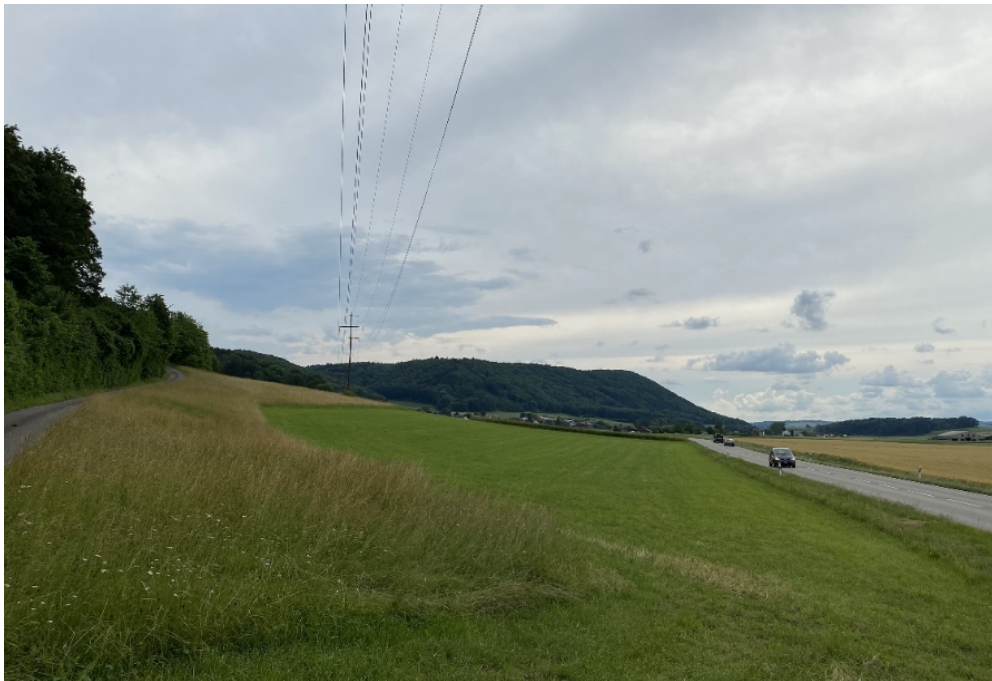
Abb. 1: Abbauperimeter mit inzwischen zurückgebauter Freileitung
